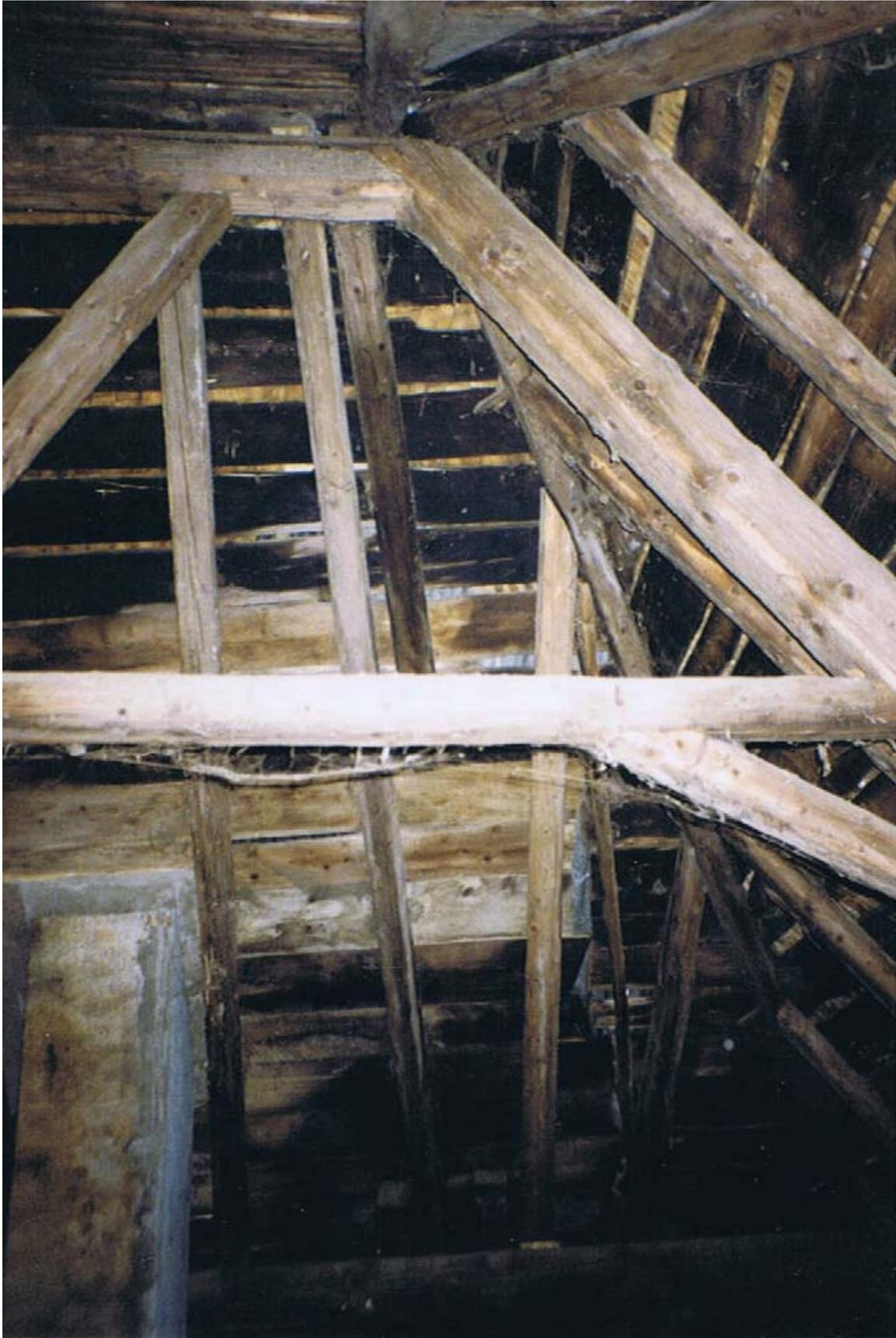
Une charpente en bon état et les lambris noircis par les fumées d'autrefois, alors que celles-ci montaient probablement directement au niveau du toit sans qu'il n'y ait de plafond intermédiaire. Des réfections ultérieures montrent la pose de nouveaux lambris ainsi que l'enlèvement du tavillon en certaines places.
