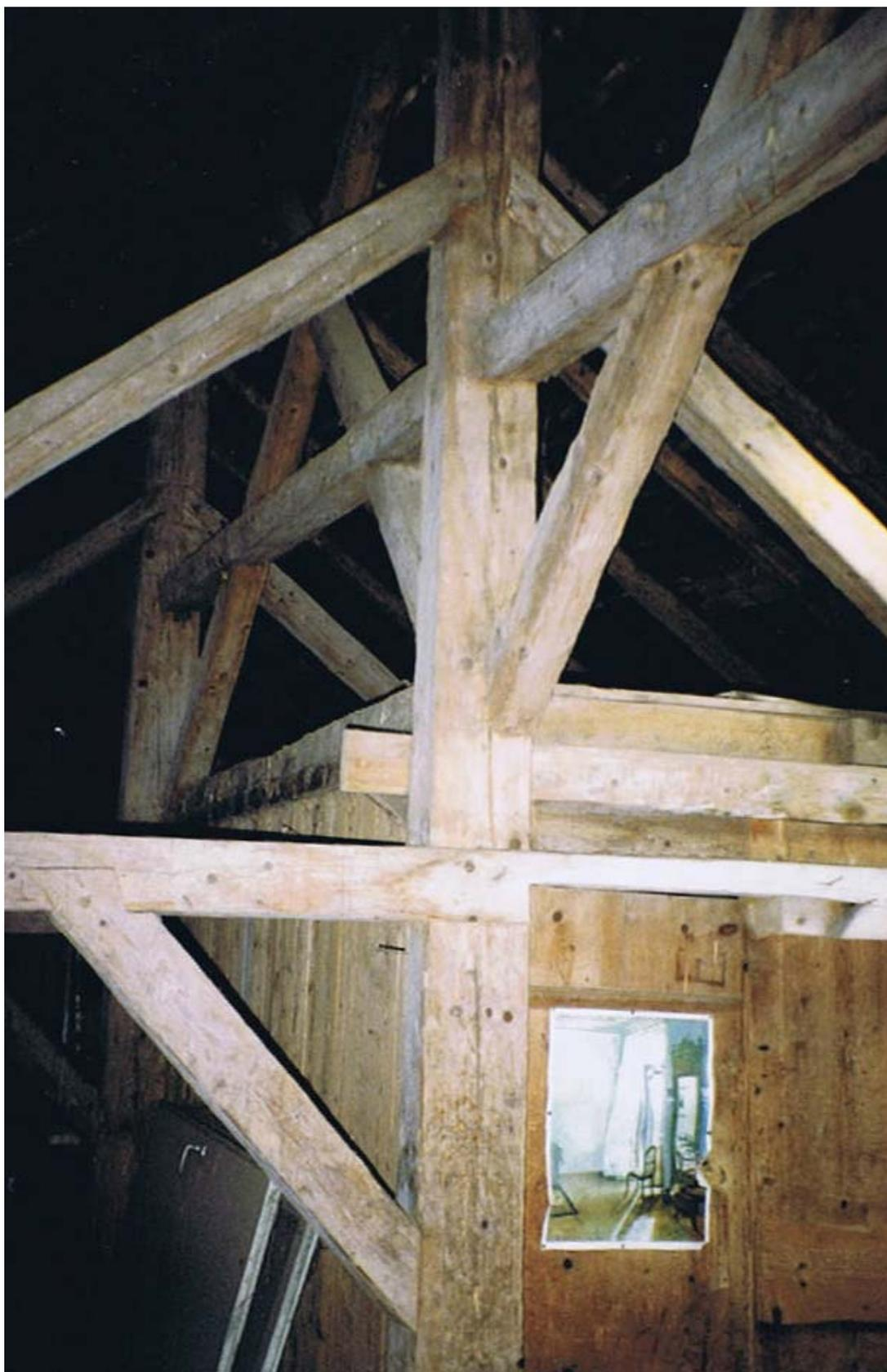
Charpente et « caisson » de la chambre à coucher qui fut sans aucun doute rajoutée après la construction du chalet, au niveau du grenier. C'est à ce moment-là probablement que fut établi le plancher intermédiaire, soit au plus tard en 1833 (date lue sur les planches de la chambre, à voir ci-dessus).
